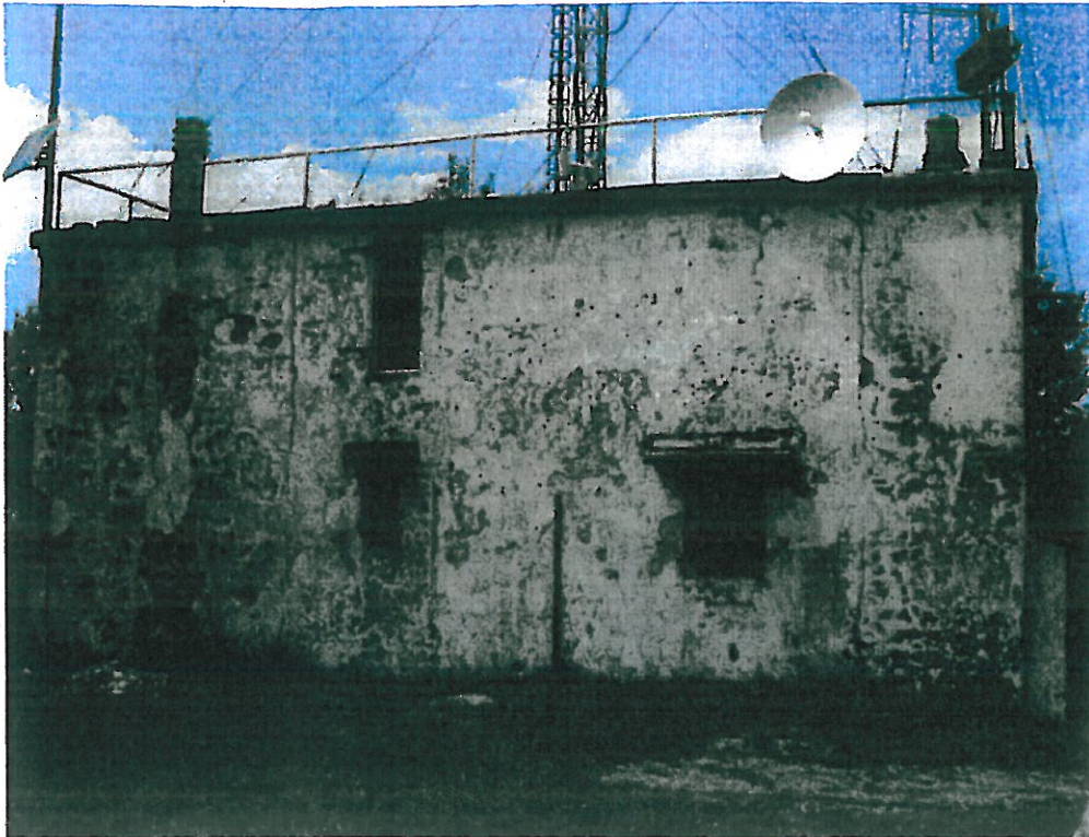
5 – Particolare della facciata nord
