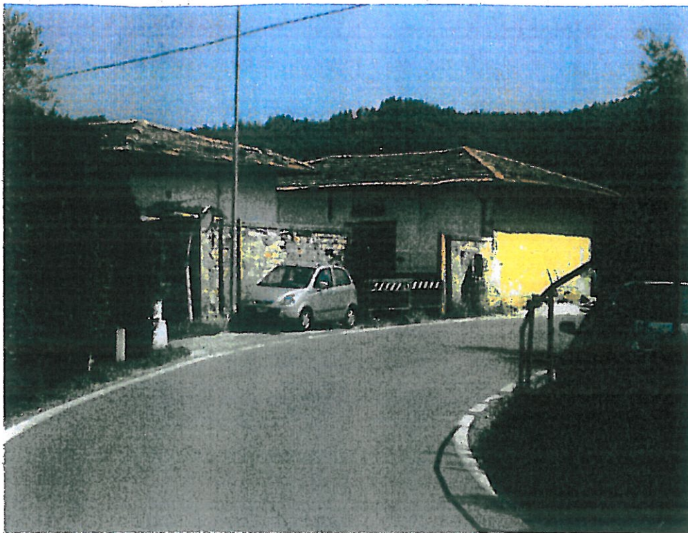
1 – Veduta del fabbricato dalla strada
