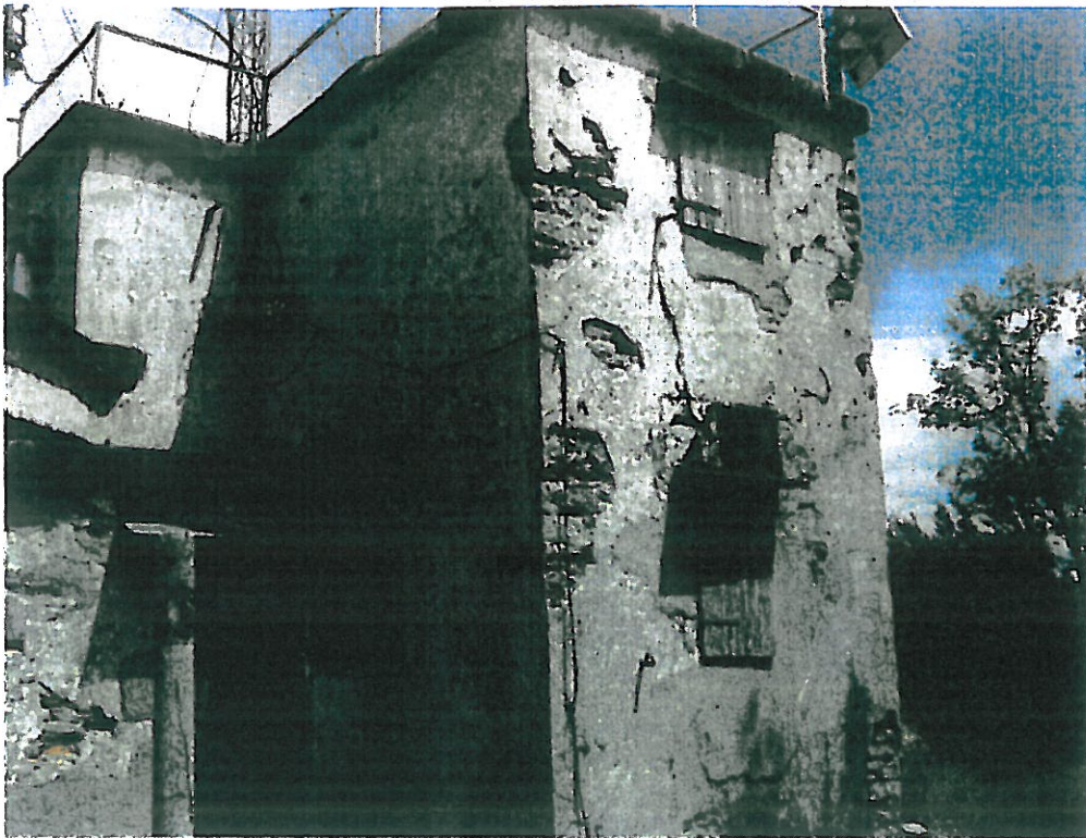
3 – Particolare della facciata est
