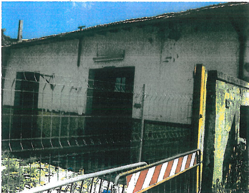
2 – Particolare della facciata principale
